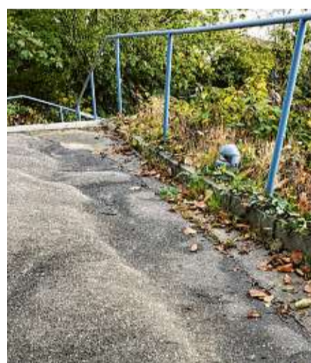
Welliger Weg, schiefe Geländer: Die Treppe ist marode Katharina Apostolidis (2)
