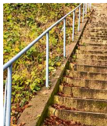
Die Treppe zum Fährhaus hat Risse und ist stellenweise abgesackt
